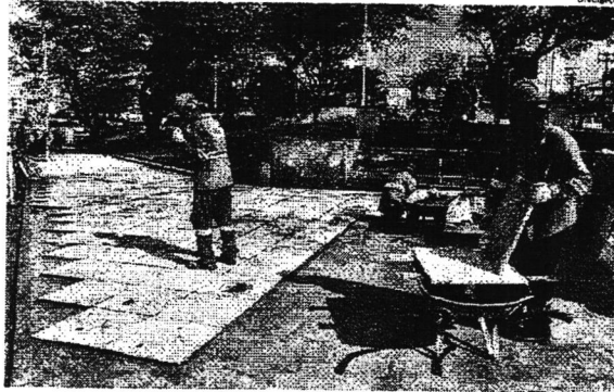
Obras na Praça da Bíblia já estão em estágio bem avançado, faltando apenas detalhes de acabamento
