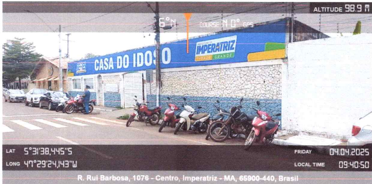
Foto 1 – Vista fachada principal.
