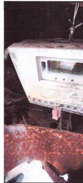
Foto 11 – Detalhe do quadro de medição. Necessita de troca do mesmo e instalação de dispositivos de proteção (disjuntor do quadro de medição).
