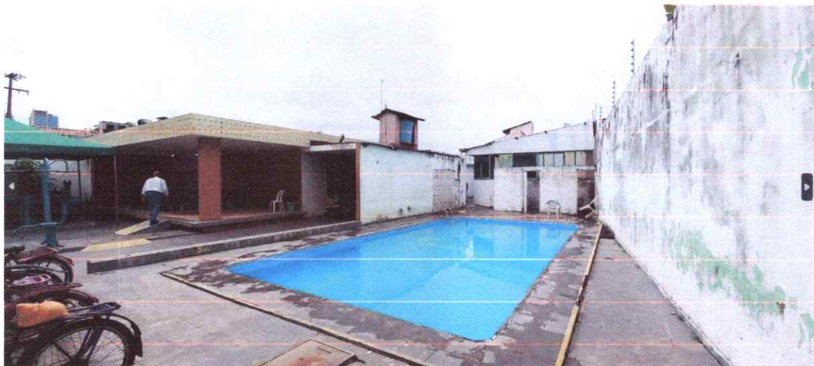
Foto 2 – Vista fachada frontal interna.
