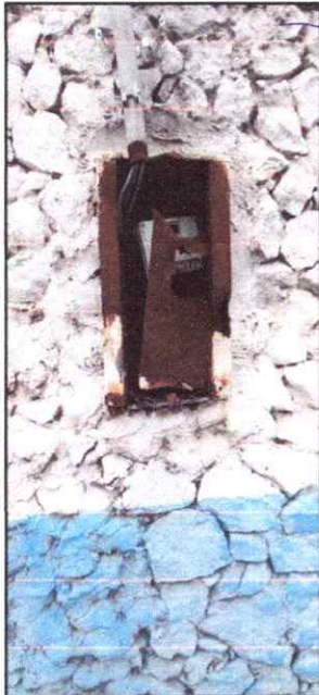
Foto 11 – Detalhe do quadro de medição. Necessita de troca do mesmo e instalação de dispositivos de proteção (disjuntor do quadro de medição).
