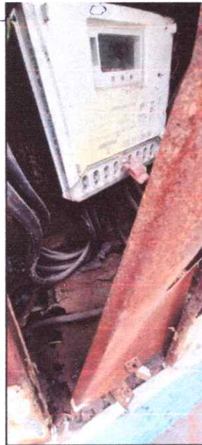
Foto 11 – Detalhe do quadro de medição. Necessita de troca do mesmo e instalação de dispositivos de proteção (disjuntor do quadro de medição).
