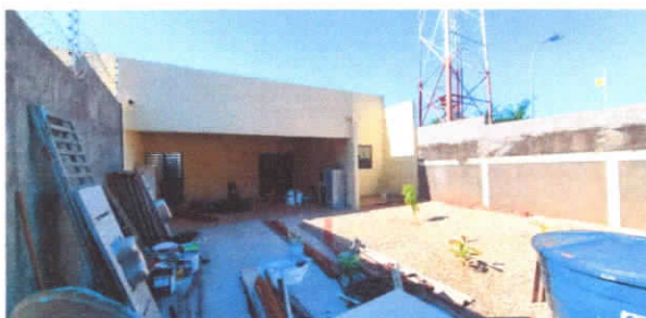
Foto 2 – Vista fachada frontal interna.
