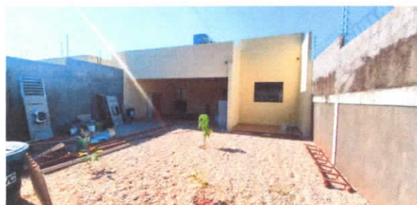
Foto 3 – Vista fachada frontal interna.
