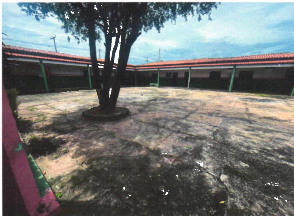
Área de circulação -- pátio aberto
